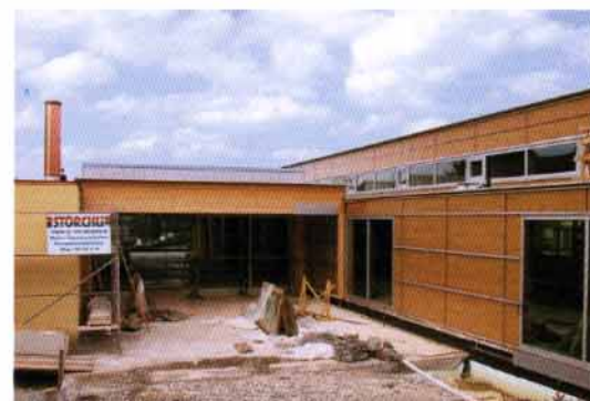
Der Eingangsbereich verbindet die alte Halle (links) mit dem Passivhaus-Neubau (rechts)
