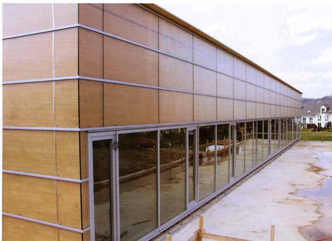
Die Pfosten-Riegel-Konstruktion nach Osten
