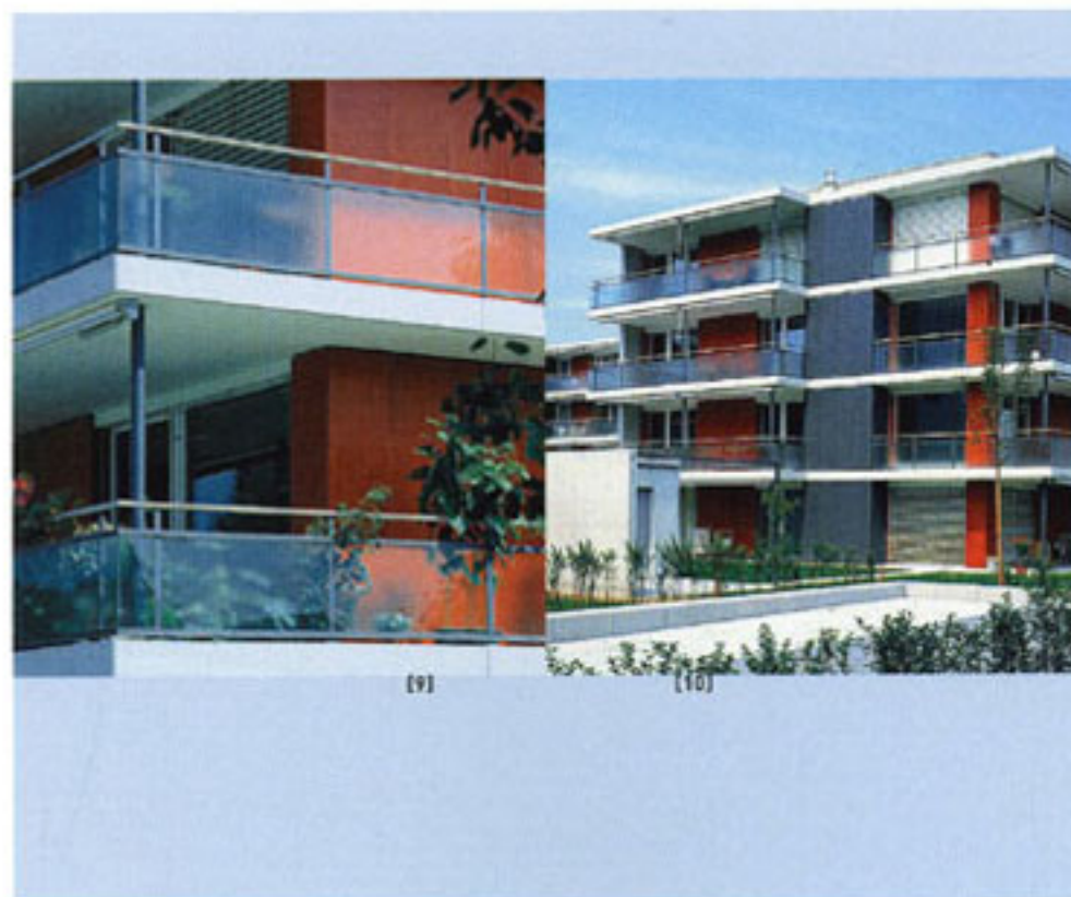
[9] Massivbauweise mit Aussendämmung und Holzverkleidung bzw. Verputz [Foto: Anliker AG Generalunternehmung].
